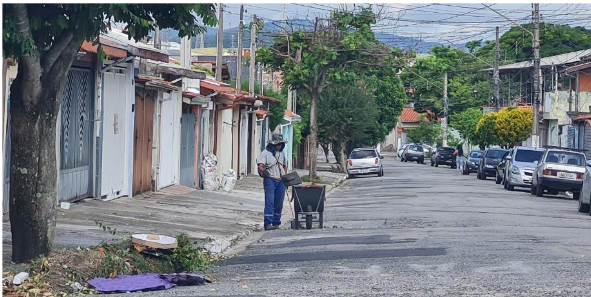
Figura 58: Manutenção de passeios e vias – carrinho de mão
