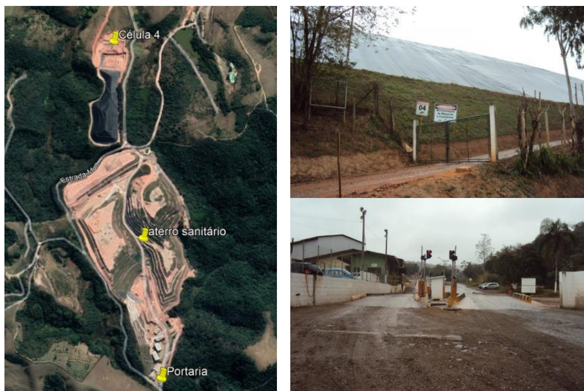
Figura 51: Vista da célula 4 e da Portaria do aterro sanitário, respectivamente Fonte: Google Earth e Felco Faleiros – julho/2017
